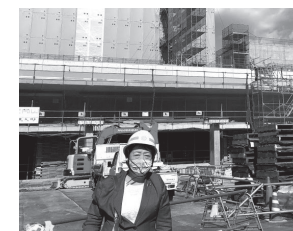
総合文化芸術センター 建設工事視察(11月4日)
